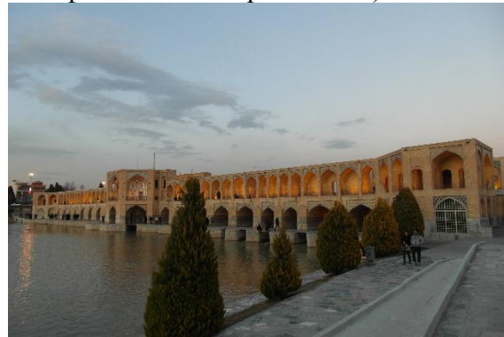
Рис. 4. Мост Хаджу через реку Заянде
